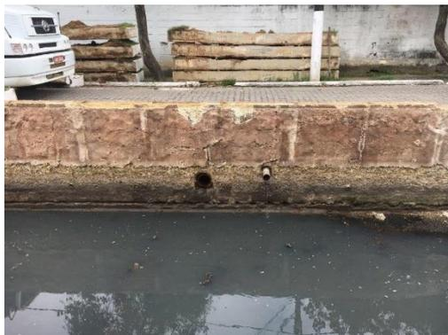
**Figura 67 - Lançamento de esgotamento sanitário no canal dos Jesuítas.**
