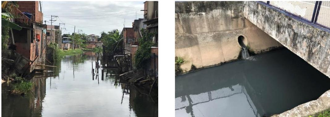
**Figura 54 - Lançamentos de esgoto nas redes de micro e macrodrenagem.**
