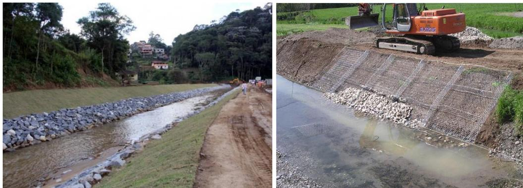
**Figura 99 - Exemplos de proteção dos taludes em córregos.**
